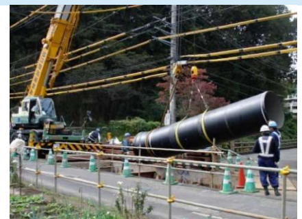
図4 交換される水道管 18
