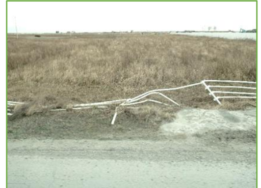
(津波により変形したガードレール)
