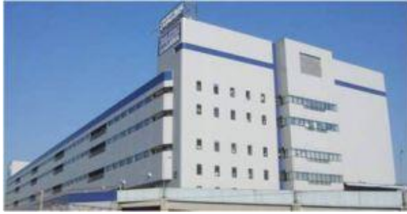
大井SRCの全景
